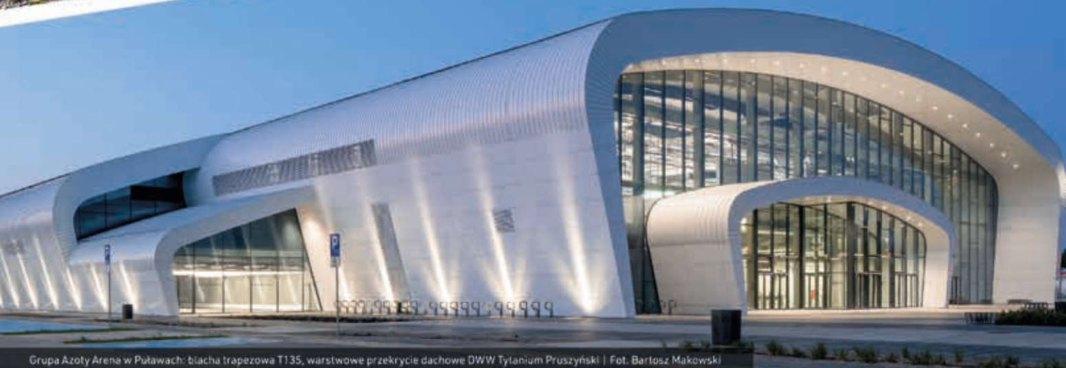
Grupa Azoty Arena w Puławach: blacha trapezowa T135, warstwowe przekrycie dachowe DWW Tytanium Pruszyński | Fot. Bartosz Makowski
